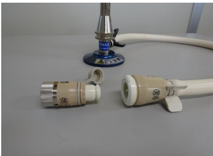
○旧式のガス栓にプラグ及びソケットを付けて対応
